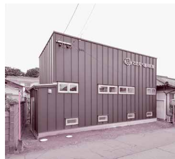
(施工事例：歯科医院)
